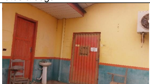
Foto 01 – Porta de Acesso à Farmácia Básica – Local de Distribuição de Medicamentos - Data 09/10/2018
