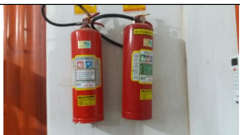
Foto 05 – Extintores da Farmácia - Data: 09/10/2018
