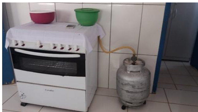
Foto 33 - Botijão de Gás dentro da Cozinha Infringindo Normas de Segurança (NBR/ABNT 13523)- Data: 25/09/2017
