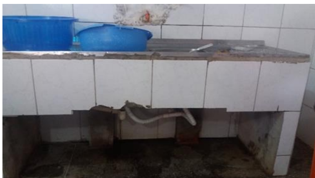
Foto 41 - Pia com acabamento inadequado, possibilitando juntar sujeira - fonte de Contaminação - contrariando o item 4.1.3 da Resolução-RDC Anvisa 216/2004 - Data 27/09/2017
