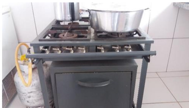
Foto 34 - Botijão de Gás Dentro da Cozinha - Infringindo Normas de Segurança (NBR/ABNT 13523)- Data: 25/09/2017
