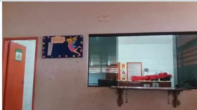
Foto 40 - Janela e Porta sem Tela de Proteção Milimétrica possibilitando a entrada de insetos, contrariando o item 4.1.4 da Resolução-RDC Anvisa 216/2004 – Data 27/09/2017
