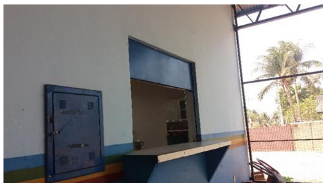
Foto 24- Janela sem tela milimétrica de proteção possibilitando a entrada de insetos, contrariando o Item 4.1.4 da Resolução-RDC Anvisa 216/2004. Data: 22/09/2017
