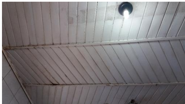
Foto 51 - Foto 50 - Forro de madeira apresenta frestas, não lavável, contrariando o item 4.1.3, 4.1.4 e 4.2.1 da Resolução-RDC Anvisa 216/2004 Data 27/09/2017
