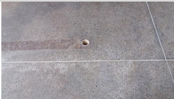
Foto 15 - Abertura no piso permite entrada de insetos e acúmulo de sujeira, contrariando o item 4.1.3 da Resolução-RDC Anvisa 216/2004 - Data: 22/09/2017
