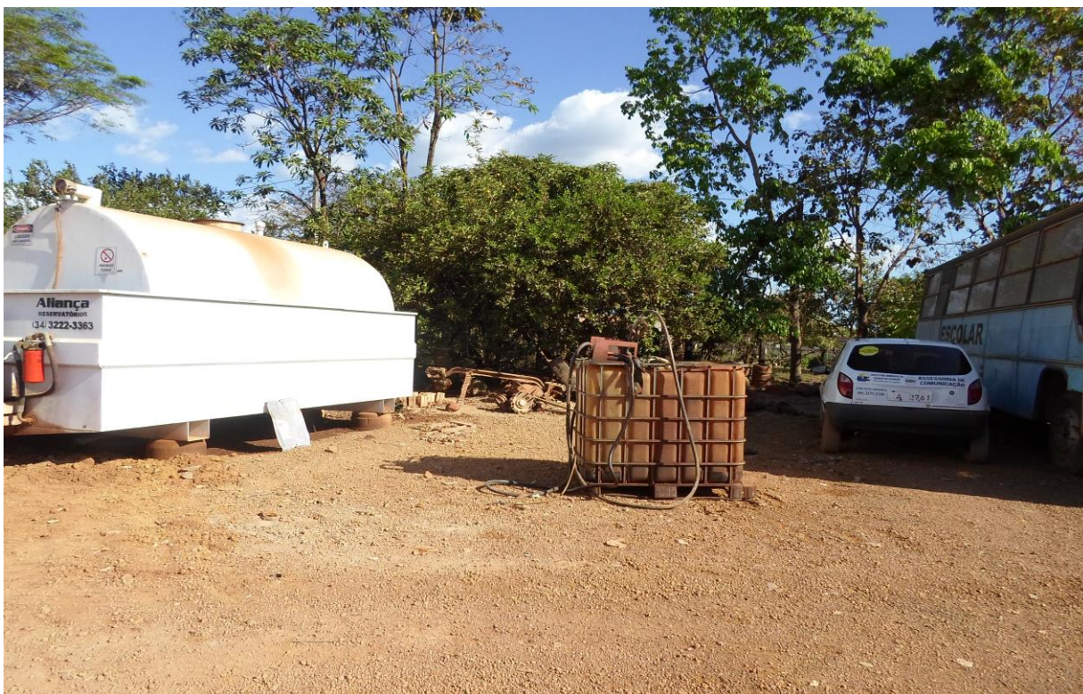
Foto 056 - Ponto de abastecimento sem cobertura – Pátio de Maquinas – Distrito União do Norte – Peixoto de Azevedo MT
