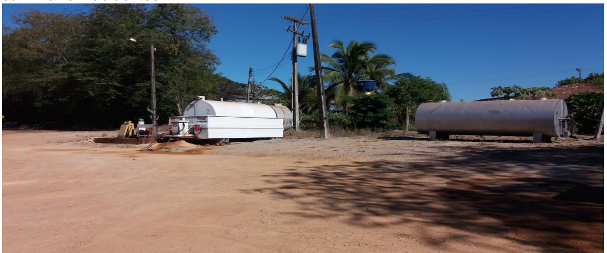
Foto 047 - Ponto de abastecimento próximo a transformador de energia elétrica – Pátio de Máquinas – Peixoto de Azevedo MT.
