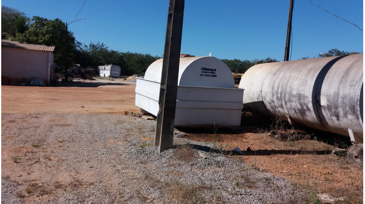
Foto 052 - Ponto de abastecimento sem cobertura – Pátio de Maquinas – Z. Urbna – Peixoto de Azevedo MT
