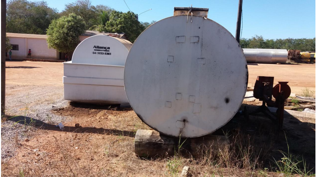
Foto 050 - Ponto de abastecimento sem cobertura – Pátio de Maquinas – Z. Urbna – Peixoto de Azevedo MT
